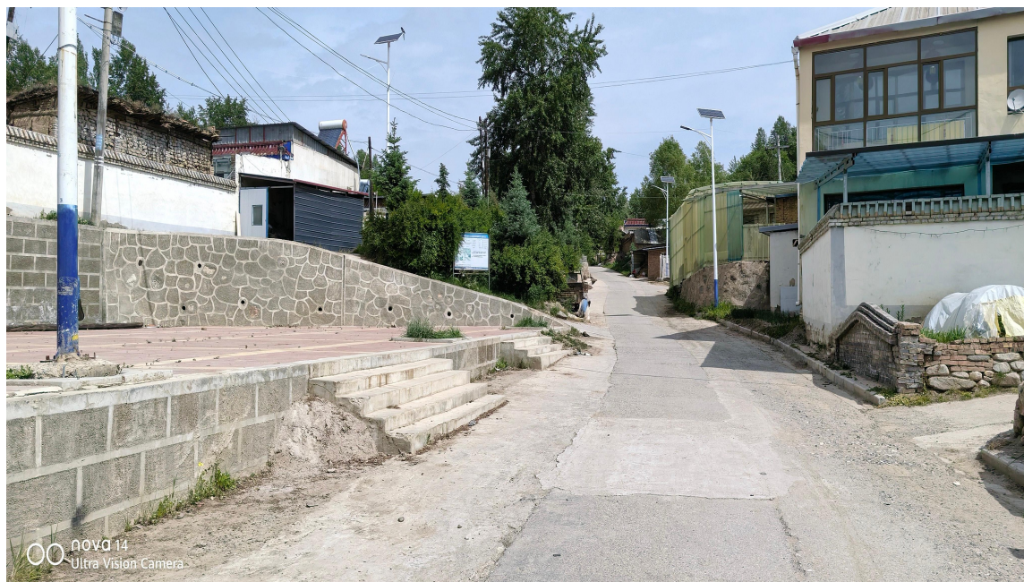
供水管网与入户管网地貌 图片 2-2-4
