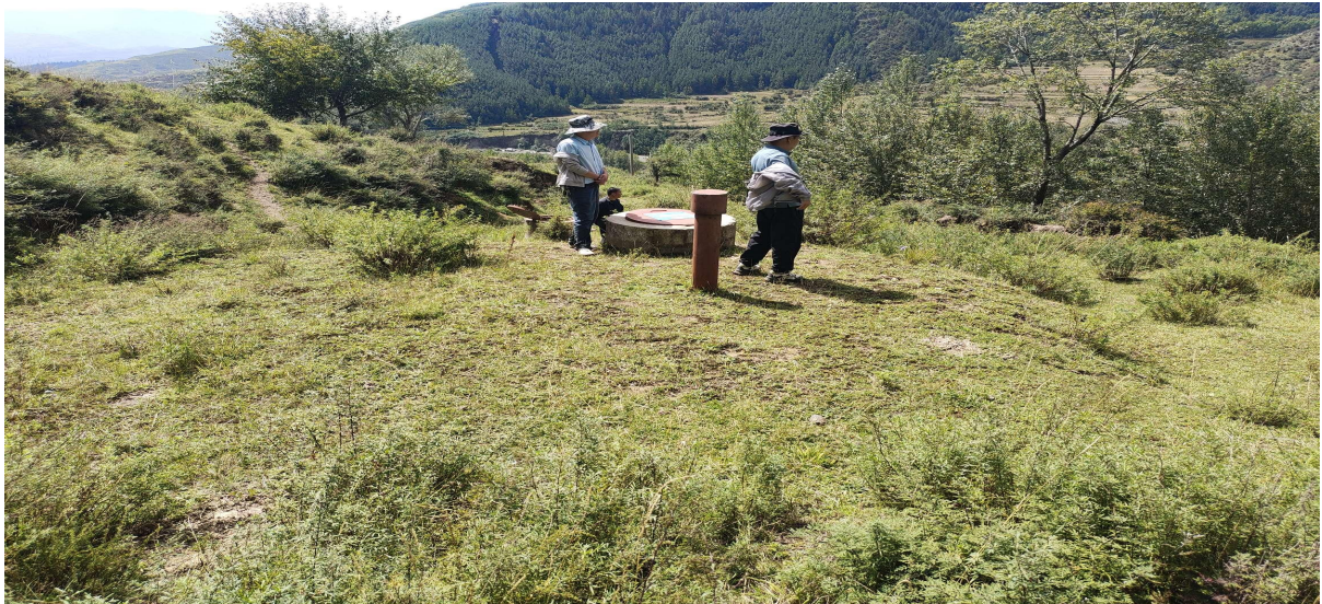
已建蓄水池运行良好
