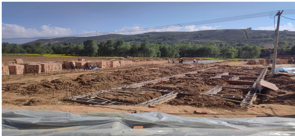
田家寨镇马场沟门安置点现状
