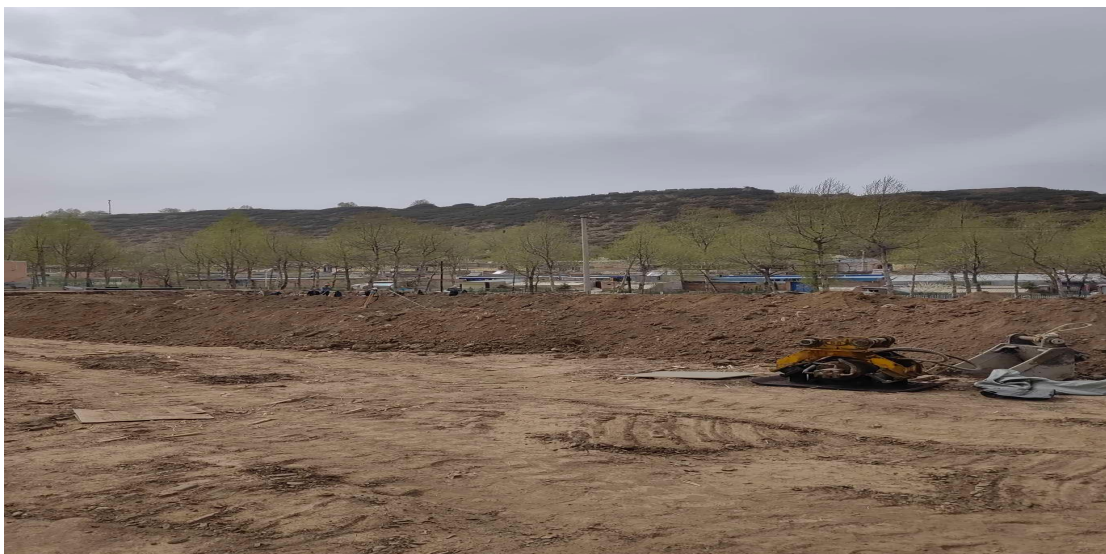
青峰村一期安置点现状
