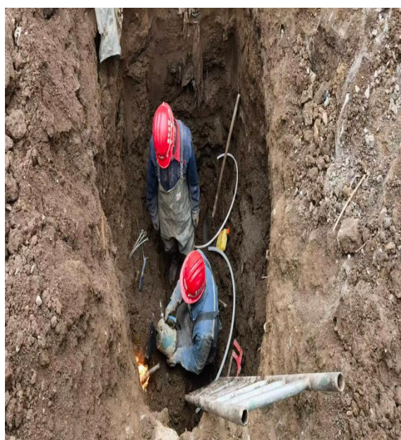
管道维修现状
