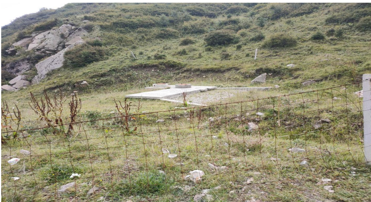
石卡沟 2#水源地（2017）
