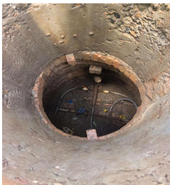
已建阀门井现状情况
