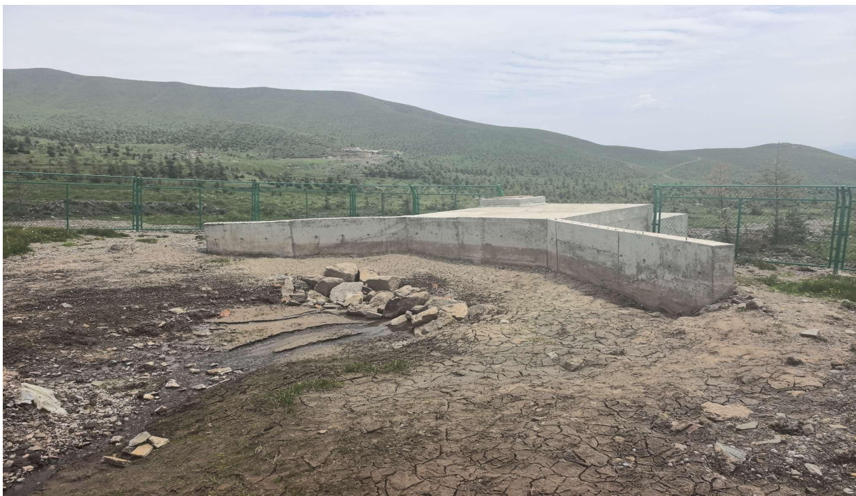
石卡沟 1#水源地（2024）
