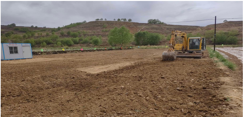
田家寨镇川坡根安置点现状
