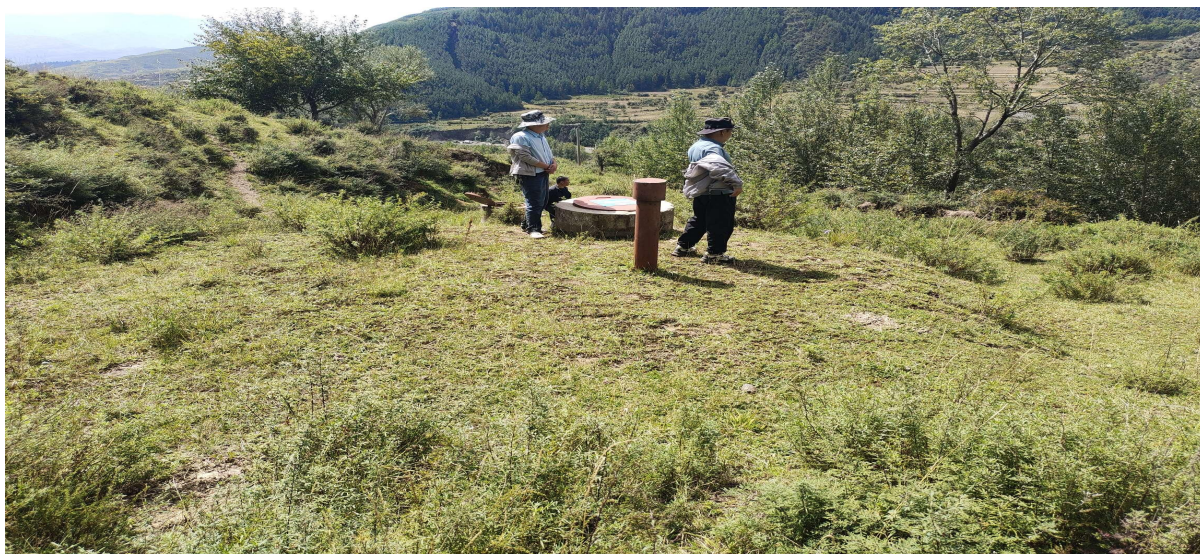
已建蓄水池运行良好
