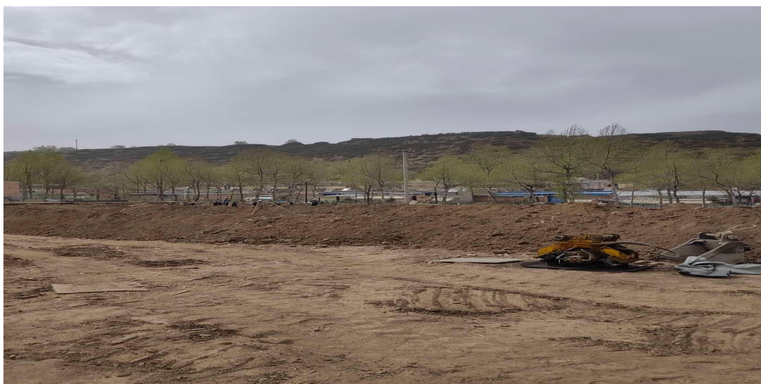
青峰村一期安置点现状
