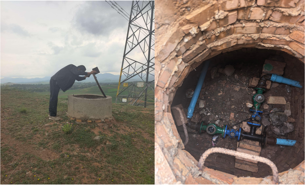
蓄水池前已建阀门井现状
