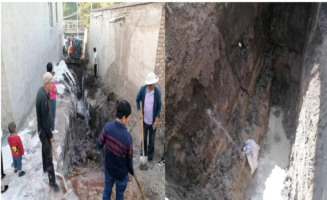
村民自行维修现状照片
