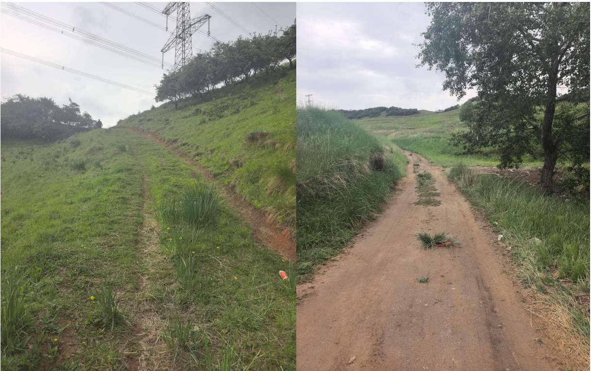
蓄水池前已建输水支管工程现状
