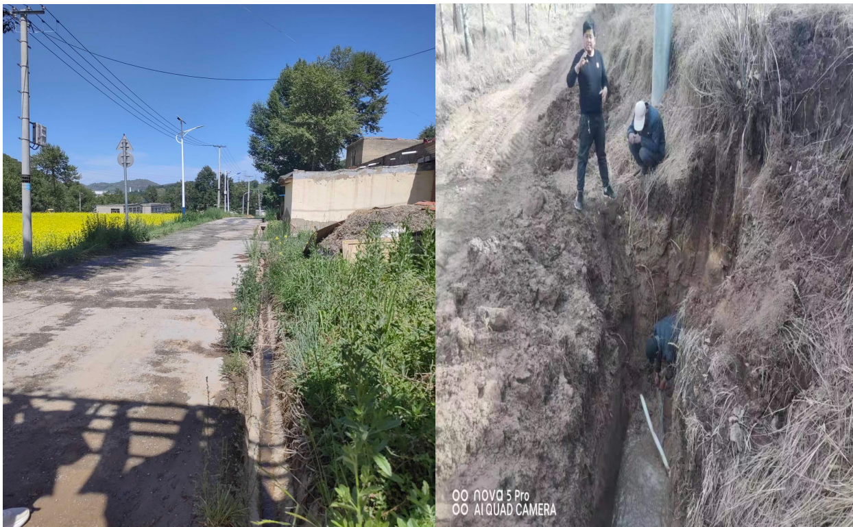
村庄原管线现状
