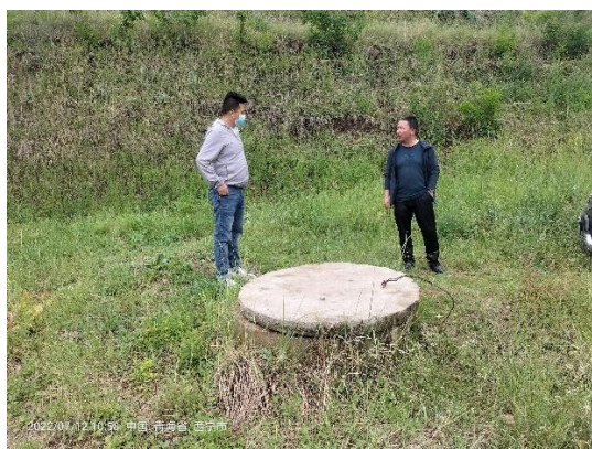
孔家村已建 30T 蓄水池
