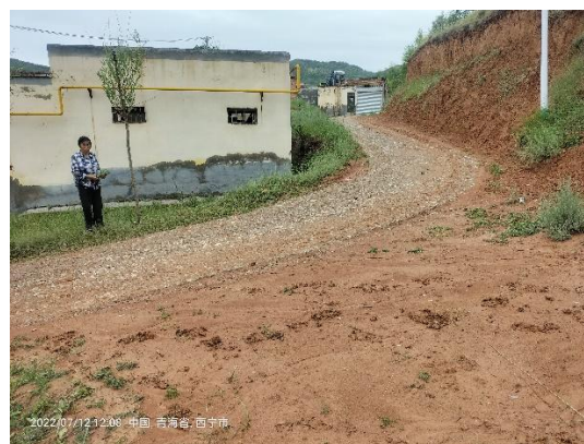
村内道路现状
