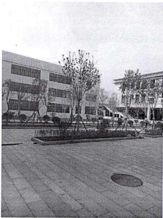
图一：多巴镇清源学校附属设施建设
